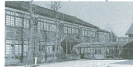
旧中部中学校校舎1棟
